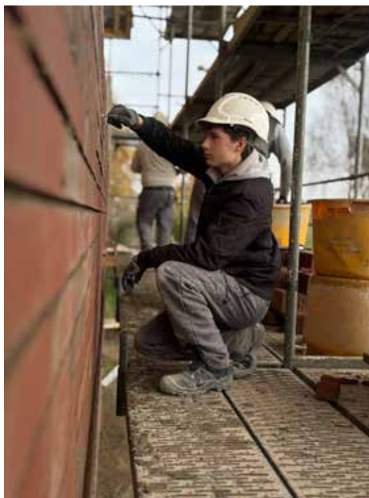
©Fotos: Dreyer Hochbau
